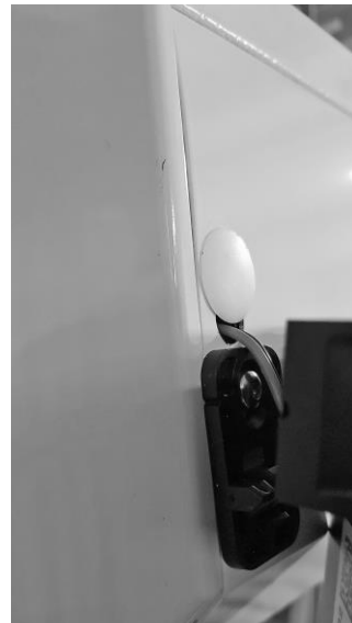
4. Panel einklicken und Verschlusskappe setzen
