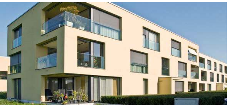
Intégration harmonieuse dans le bâtiment
