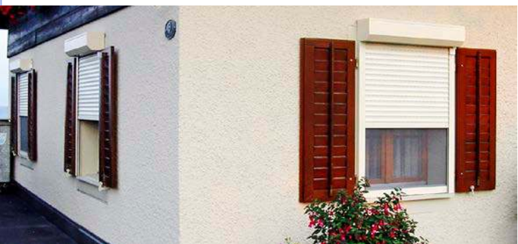
L'apparence d'origine est maintenue (volets)
