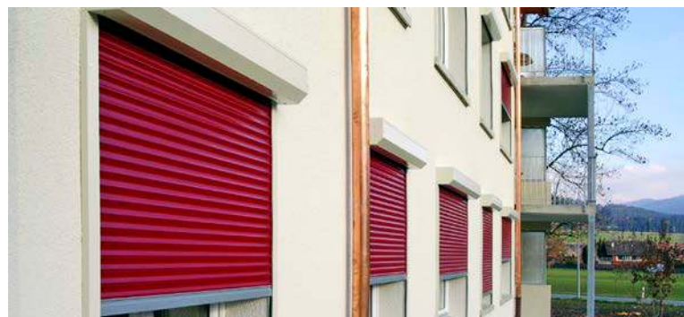
Des volets roulant remplacent les stores vénitiens et permettent une commande automatisée
