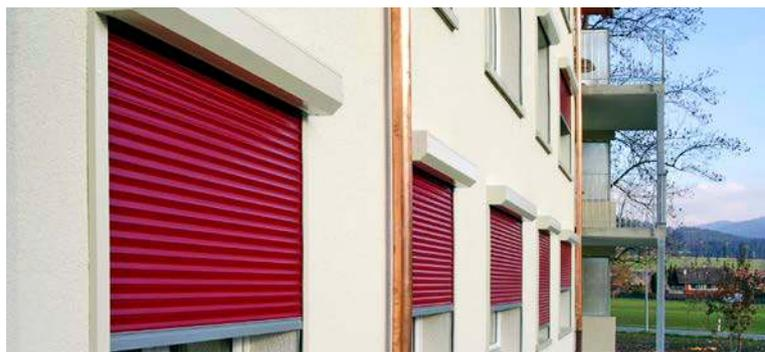
Rollladen ersetzen Jalousien und ermöglichen automatische Steuerung
